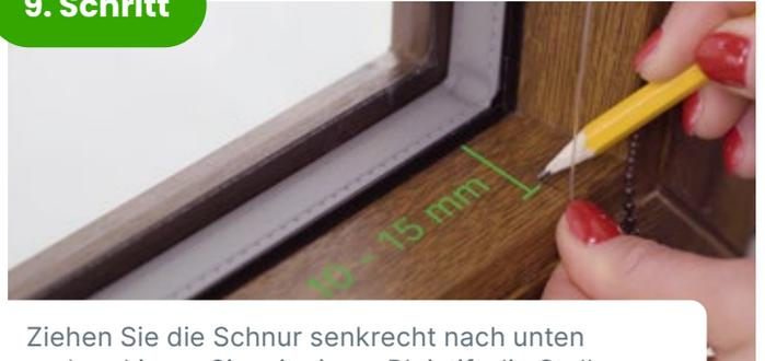
Ziehen Sie die Schnur senkrecht nach unten und markieren Sie mit einem Bleistift die Stelle für **die Bohrung für den Fixierstift**. Wir empfehlen, den Stift 10 bis 15 mm von der Kante der Glasleiste zu platzieren. (Bei Dreifachverglasung ca. 5 mm.)
