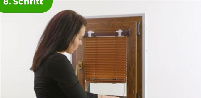
Lassen Sie die Lamellen soweit herunter, dass sie **ca. 10 cm** von der unteren Glasleiste entfernt sind.
