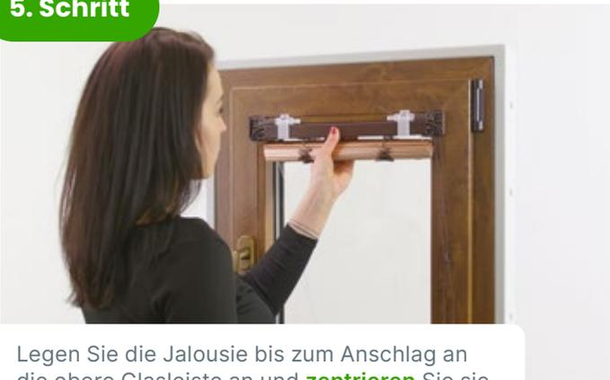
Legen Sie die Jalousie bis zum Anschlag an die obere Glasleiste an und **zentrieren** Sie sie.
