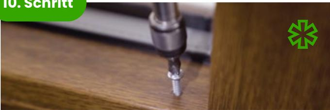
**Bohren Sie** an den markierten Stellen mit Hilfe der Schraube zur Befestigung der Jalousie vorsichtig **ein Loch für den Fixierstift**. Auch eine Bohrung mit einem Durchmesser von 27 mm ist möglich.
