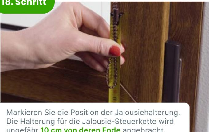
Markieren Sie die Position der Jalousiehalterung. Die Halterung für die Jalousie-Steuerkette wird ungefähr 10 cm von deren Ende angebracht.
