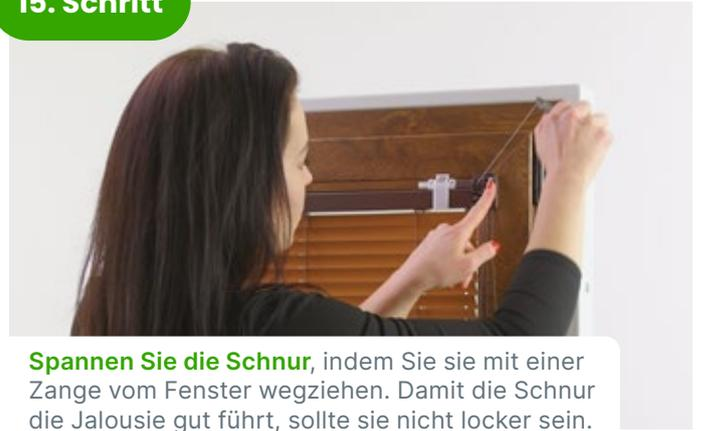
Spannen Sie die Schnur, indem Sie sie mit einer Zange vom Fenster wegziehen. Damit die Schnur die Jalousie gut führt, sollte sie nicht locker sein.
