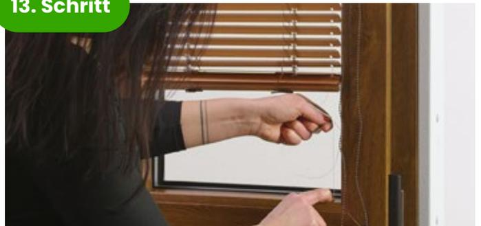
**Halten Sie** mit einer Hand **den Fixierstift fest** und ziehen Sie mit der anderen Hand an der Schnur, um sie in der Leiste zu befestigen.
