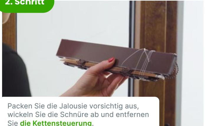
Packen Sie die Jalousie vorsichtig aus, wickeln Sie die Schnüre ab und entfernen Sie **die Kettensteuerung**.
