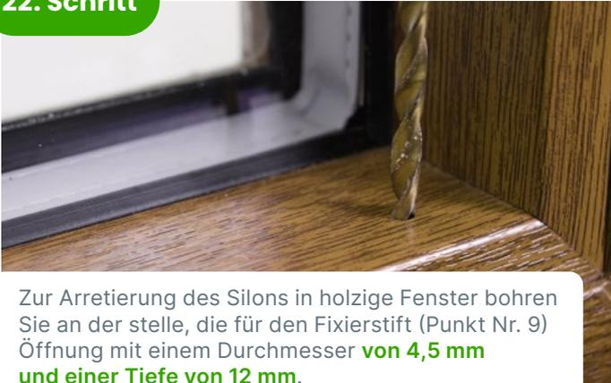
Zur Arretierung des Silons in holzige Fenster bohren Sie an der stelle, die für den Fixierstift (Punkt Nr. 9) Öffnung mit einem Durchmesser **von 4,5 mm** und einer Tiefe **von 12 mm**.
