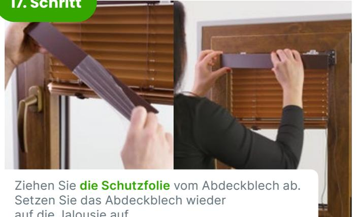
Ziehen Sie die Schutzfolie vom Abdeckblech ab. Setzen Sie das Abdeckblech wieder auf die Jalousie auf.
