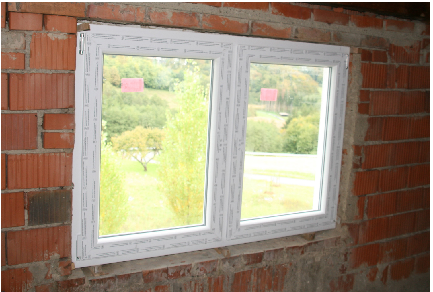
Das neue Kunststofffenster wurde exakt nach Massangaben gefertigt und passte perfekt in die Mauernische. Mit ein paar Holzkeilen konnte es stabil fixiert werden.
