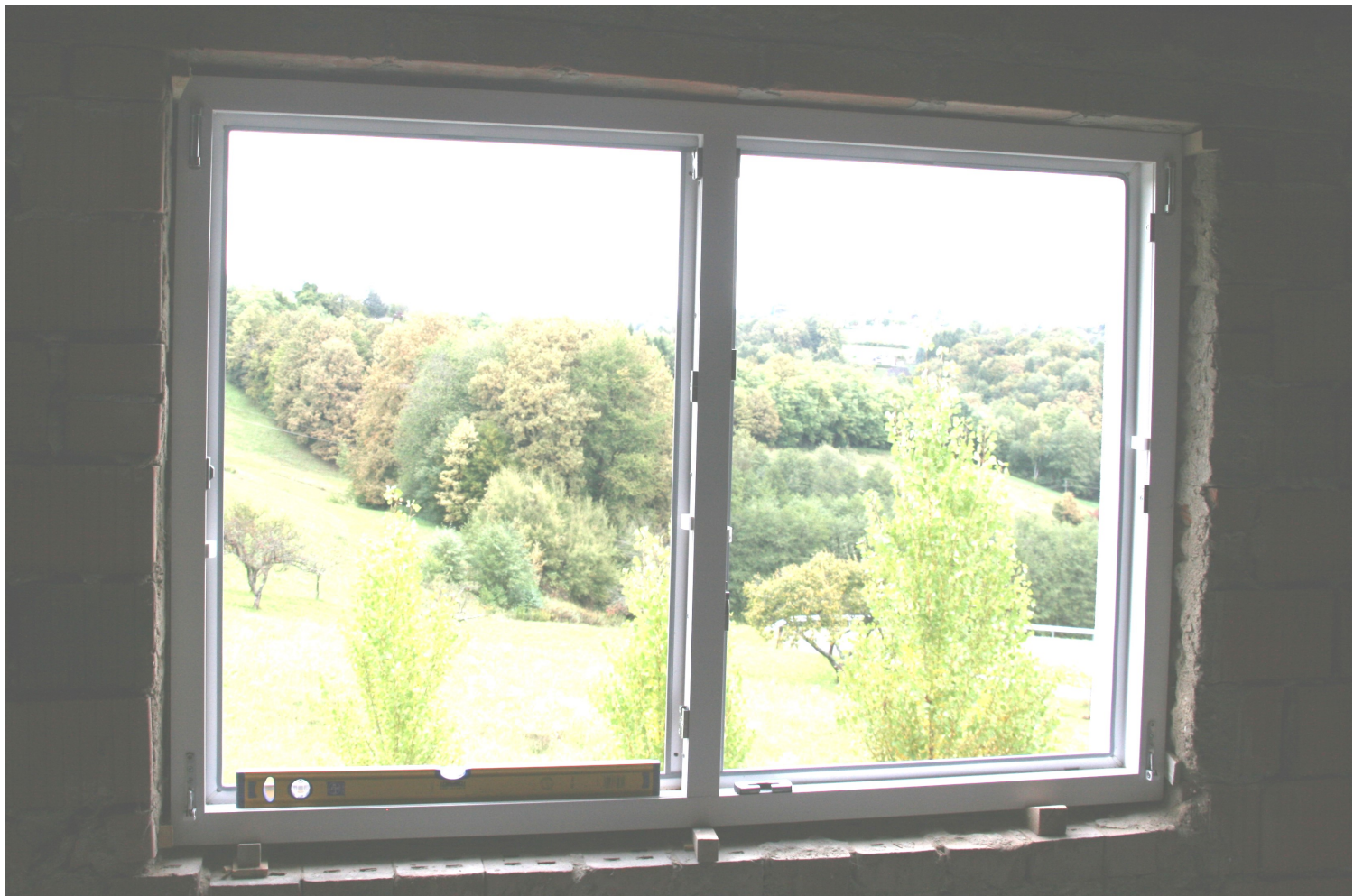
Das neue Kunststofffenster wurde exakt nach Massangaben gefertigt und passte perfekt in die Mauernische. Mit ein paar Holzkeilen konnte es stabil fixiert werden.
