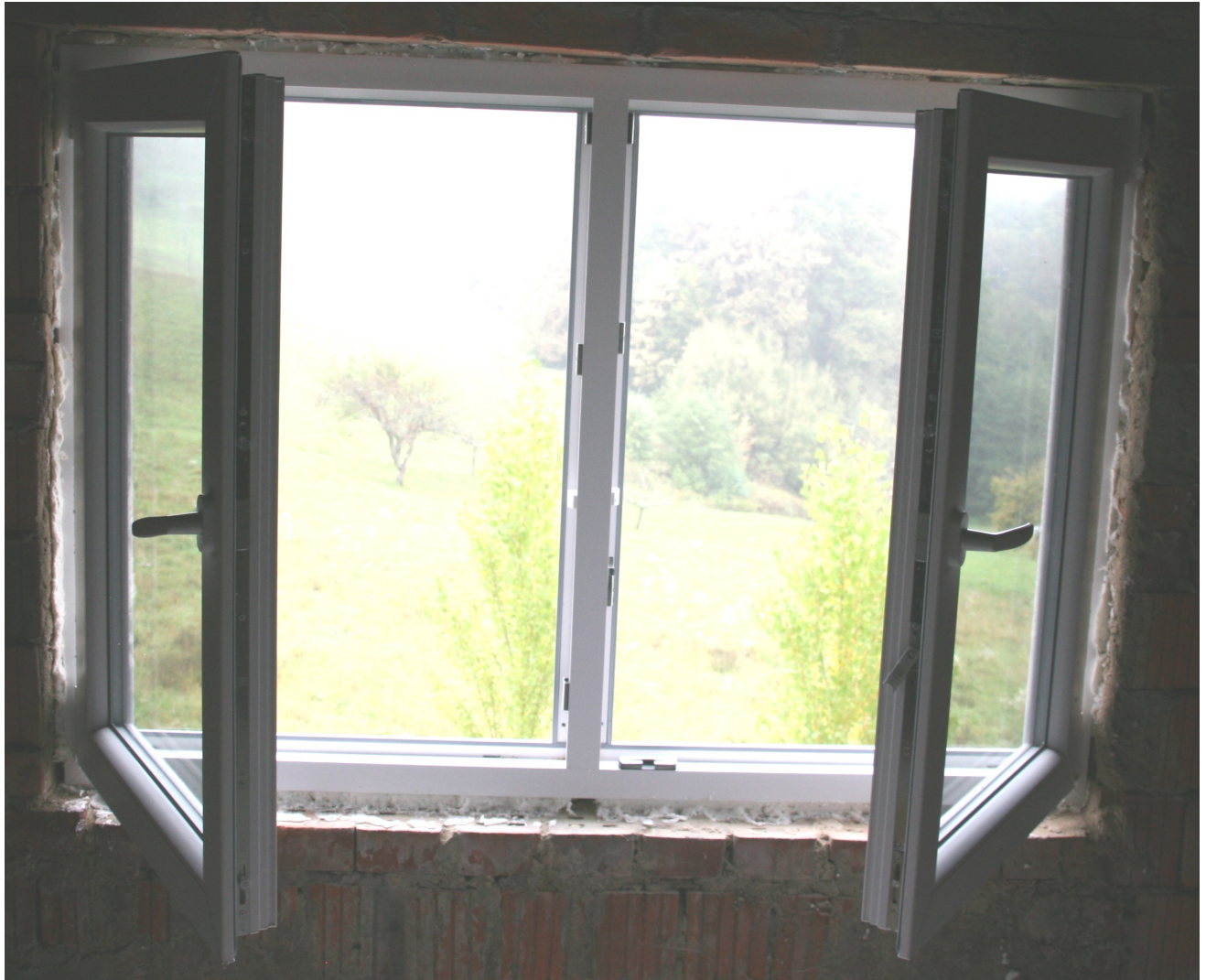
Mit nur einer Dose PU-Schaum wurde das neue Fenster fest in die Mauernische fixiert.
