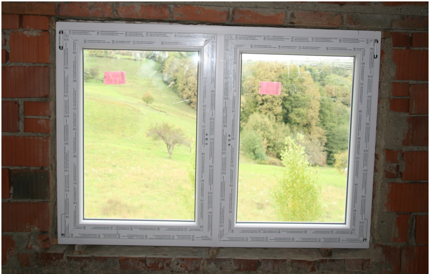
Mit nur einer Dose PU-Schaum wurde das neue Fenster fest in die Mauernische fixiert.
